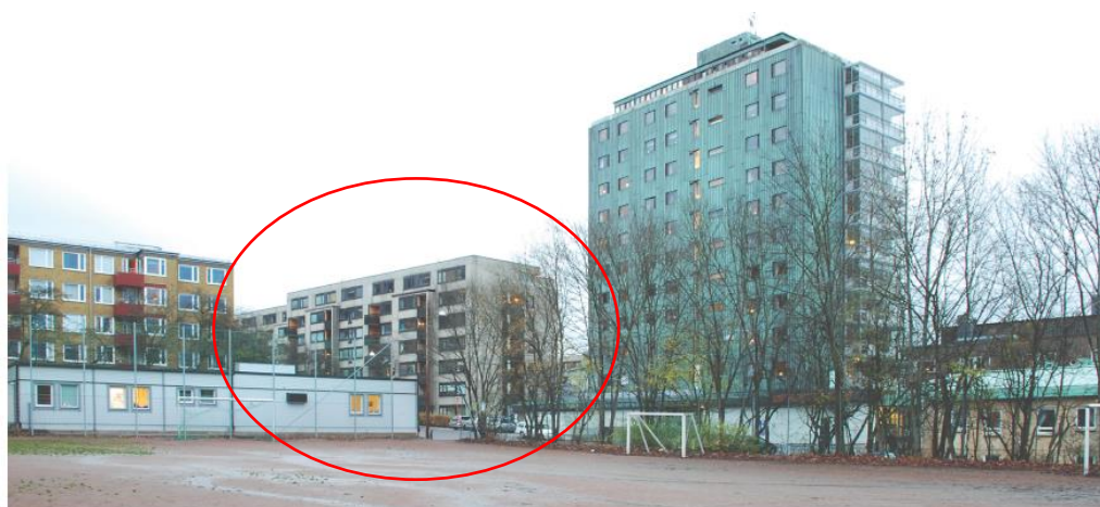
Foto; befintlig bebyggelse, UNIT Arkitektur AB
