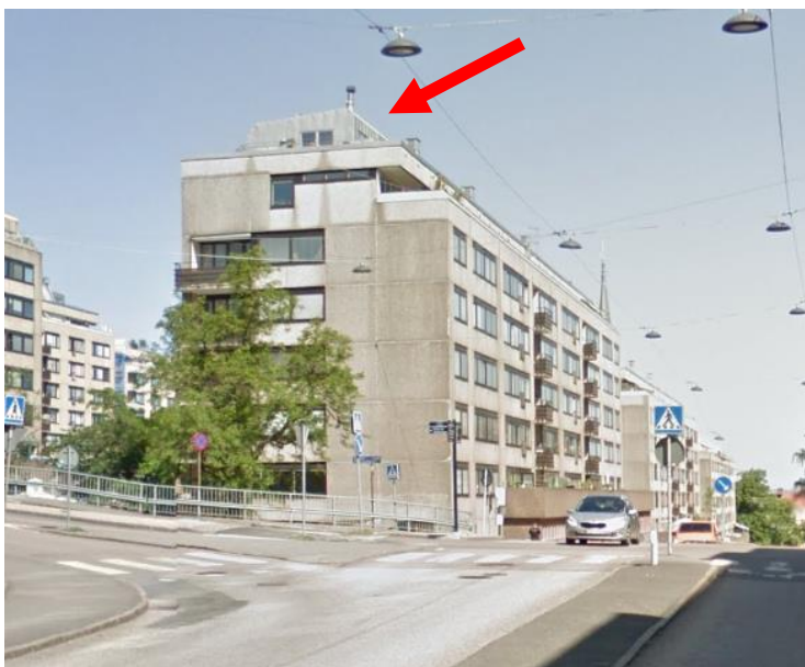
Befintlig påbyggnad i området; indragen våning
